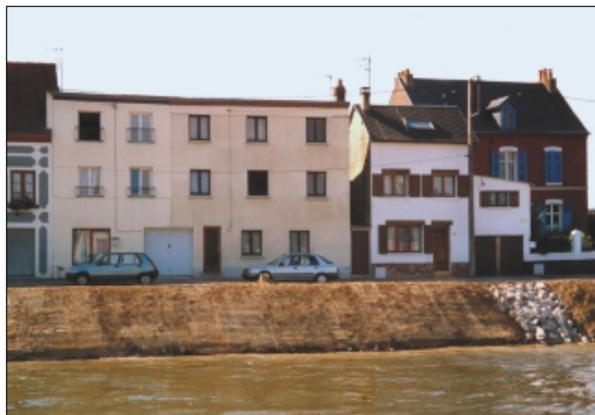
Vue de la berge après recouvrement de terre végétale et hydroensemencement pour que l'intégration de cette nouvelle structure se fasse plus rapidement dans son environnement.
