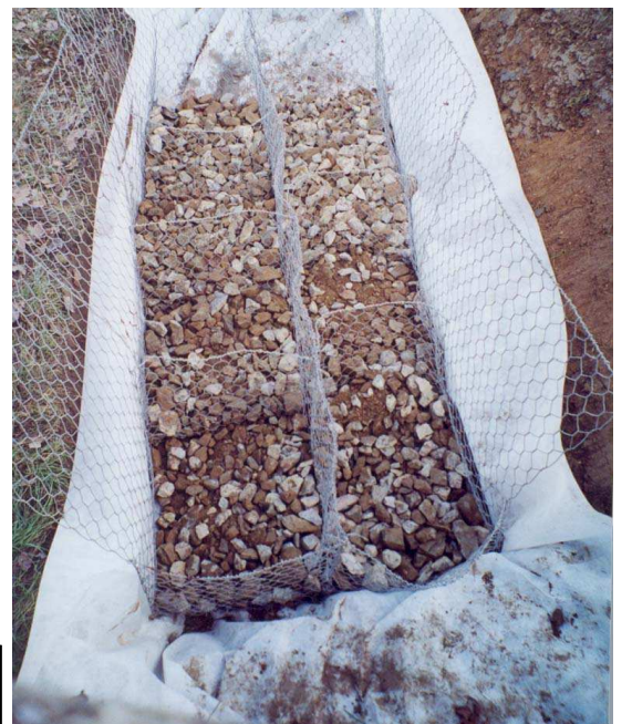
Digue de la Faute sur Mer réalisée en mars 2010 Aperçu de la digue suite à la violence de la tempête Xynthia Parfait comportement de l'ouvrage en double torsion
