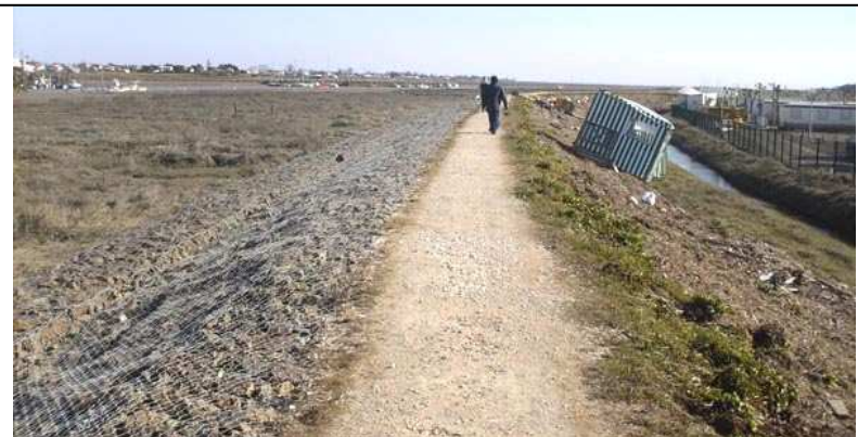
Digue de la Faute sur Mer réalisée en mars 2010 Aperçu de la digue suite à la violence de la tempête Xynthia Parfait comportement de l'ouvrage en double torsion
