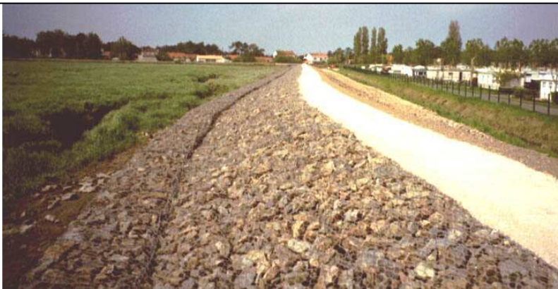
Digue de la Faute sur Mer réalisée en mars 2010 Aperçu de la digue suite à la violence de la tempête Xynthia Parfait comportement de l'ouvrage en double torsion
